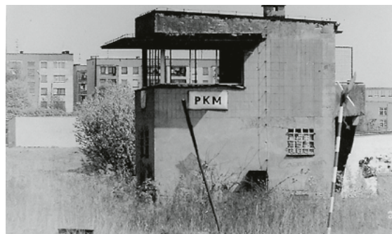
Fotografia. Stacja Kolejowa Pyskowice Miasto, nieczynna nastawnia PKM oczekująca likwidacji. Z archiwum prywatnego i dzięki uprzejmości A. Kaliszewskiego
